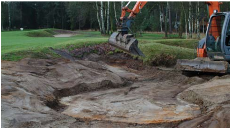
Hole 13, machine in bunker tijdens de werkzaamheden.
